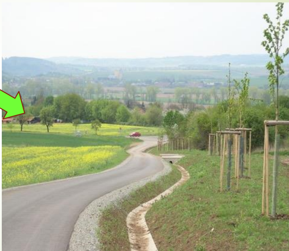
stav po realizaci
